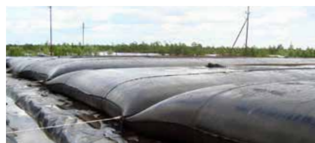
ACETube® el tubo de deshidratación, el componente clave del sistema de deshidratación, está hecho de geotextil de alta permeabilidad con aberturas óptimas para mejorar el rendimiento de la filtración.
