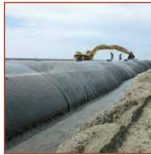
**ACETube® Geotextile Tubes**
